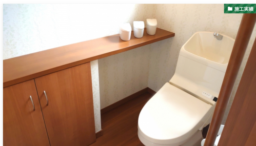
福島市 | トイレ交換・内装リフォーム工事 © June 1, 2025
