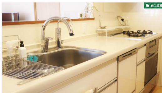
福島市 | キッチンの水漏れ修理・配管交換工事 © June 1, 2025
